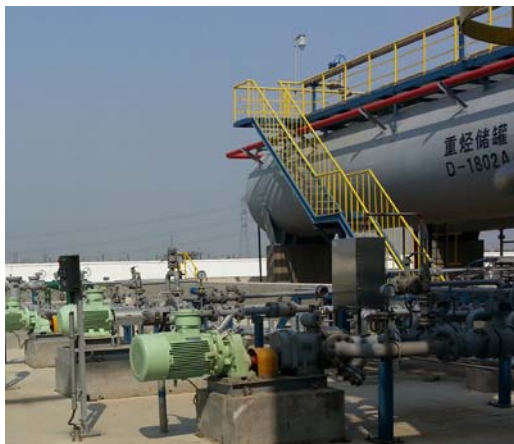
丙稀输送凸轮转子泵
