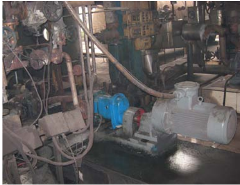
焦化厂煤沥青工况高温转子泵（ \leq 320^{\circ}\text{C} ）
