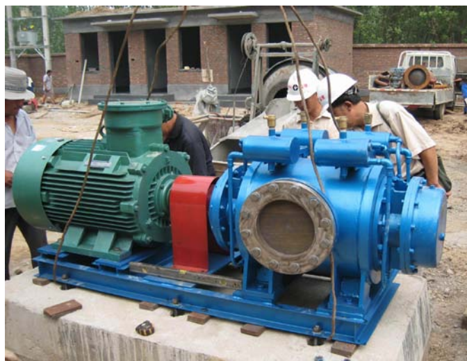
双螺杆泵安装现场
